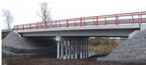
Рис. 2. Железобетонный мост с автодорожной балкой
